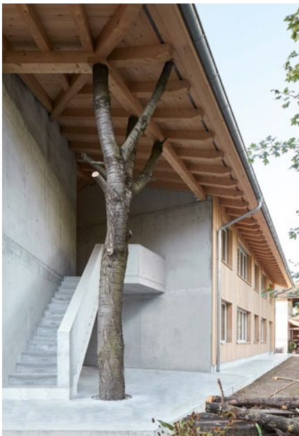
Der Baum unter dem Dach hat neben seiner Ästhetik auch eine tragende Funktion.
