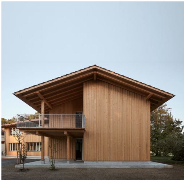
Der Baum unter dem Dach hat neben seiner Ästhetik auch eine tragende Funktion.
